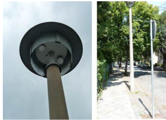
Abbildung 2-6 Straßenbeleuchtung in der Pestalozzistraße 10
