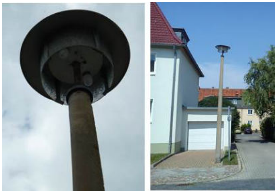
Abbildung 2-5 Straßenbeleuchtung in der Feldstraße 9
