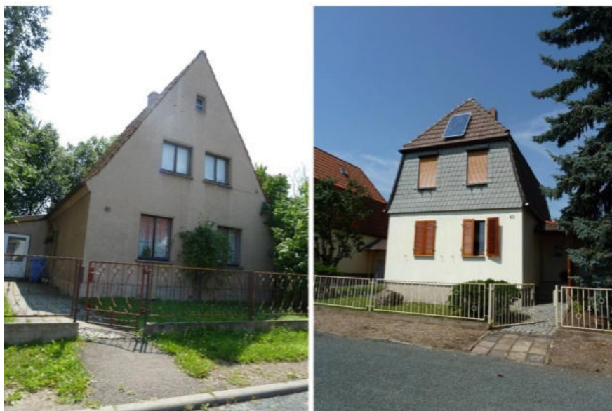
Abb. 9: Unterschiedliche energetische Bestandssituationen auf dem Gartenberg (Quelle: DSK)
